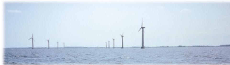
La tecnologia degli aerogeneratori da utilizzare in siti offshore è in pieno sviluppo: a livello commerciale esistono macchine da 1 MW ed esistono prototipi da circa 3 MW.
